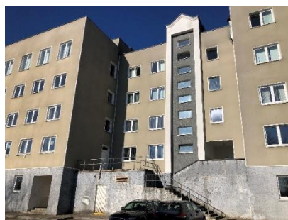
3 pav. Remontuojama pastato dalis iš rytų pusės (6D4p)
