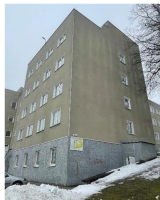
5 pav. Remontuojama pastato dalis iš šiaurinės pusės (7D4p)
