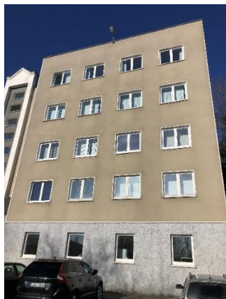
4 pav. Remontuojama pastato dalis iš rytų pusės (7D4p)
