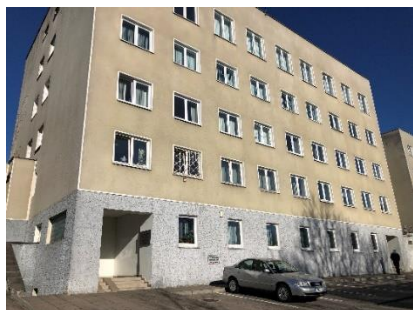
2 pav. Remontuojama pastato dalis iš rytų pusės (8D4p)
