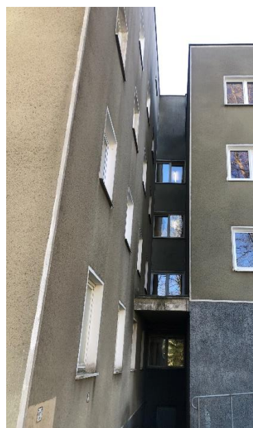
7 pav. Remontuojama pastato dalis iš šiaurinės pusės (7D4p,6D4p)
